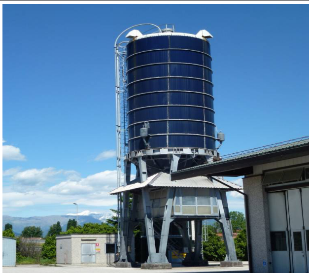
Piazzale CENTRO ESERCIZIO LADISPOLI
